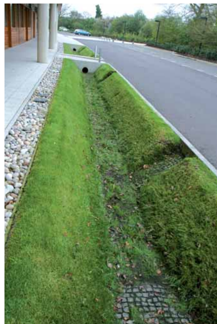
▲ Fossé végétalisé (noue) pour recueillir les eaux de ruissellements d'un parking ou d'une voirie
