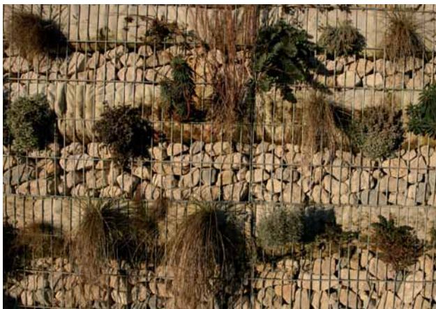
▲ A Moirans ce mur en gabions a été végétalisé
